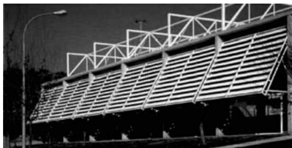
Figura 3 1. Façana sud del Pavelló Municipal de Montgat amb lames de protecció solar.
