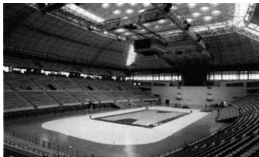
Figura 5.2. Il·luminació lateral i central al poliesportiu de l'Hospitalet. A la façana sud (zona graderies) l'envidrament és translúcid per a evitar enlluernaments.
