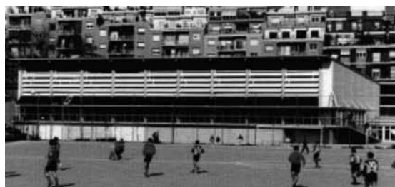
Figura 5.13 Captadors solars i lames de protecció solar al Poli-esportiu del Guinardó.
