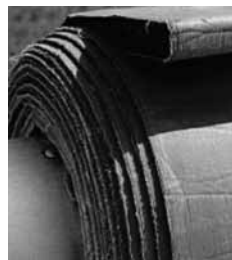
Figura 7.2 Manta tèrmica exterior del Centre d'Alt Rendiment de Sant Cugat.
