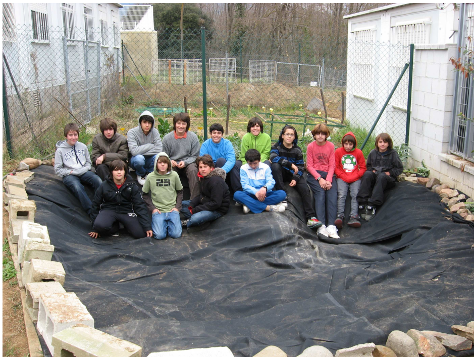
Fase 1: fi de la construcció amb la instal·lació de la lona de butil
