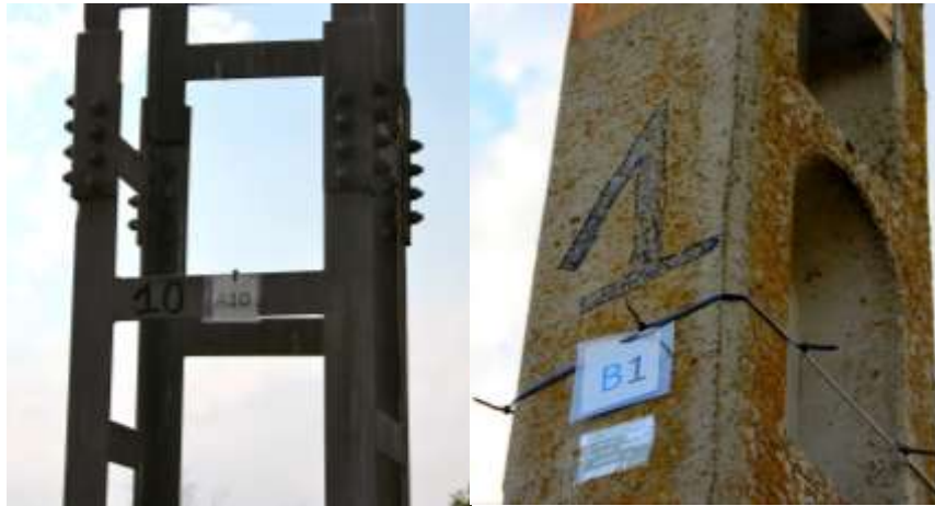
Imatges 6 i 7: Exemple del marcatge i etiquetatge d'una torre de ferro i d'una torre de formigó.
