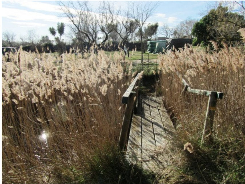
Pont sense utilitat entre el camí de la platja i el càmping el Matà. 07/01/2011.
