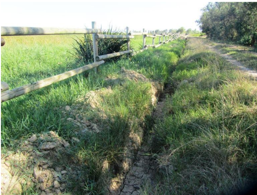
Obres per a la millora del sistema d'inundació del Matà. 13/09/2011
