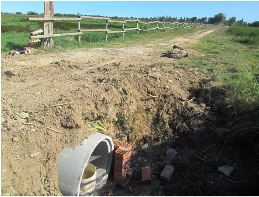
Obres per a la millora del sistema d'inundació del Matà. 13/09/2011
