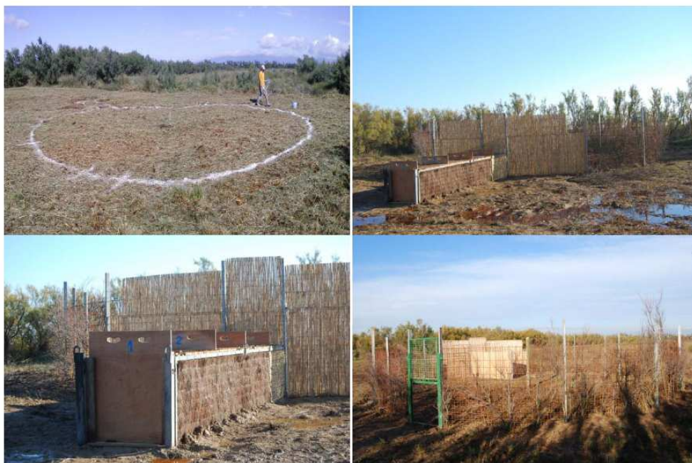
Imatges de parany-corral per a senglar instal·lat a la RNI-2, en el moment de la construcció i una vegada finalitzat.
