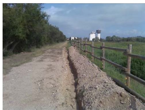
Obertura de la rasa per on s'ha fet passar la línia elèctrica que alimenta el motors elèctrics
