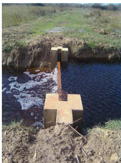
Construcció de les noves arquetes/sobreeixidors
