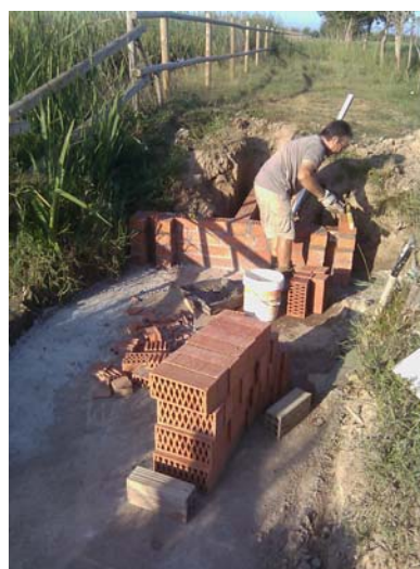
Construcció de les noves arquetes/sobreeixidors
