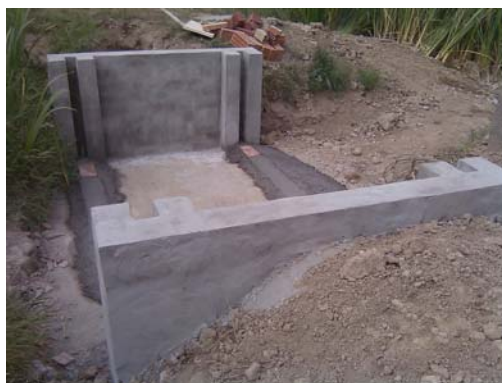
Construcció de les noves arquetes/sobreeixidors
