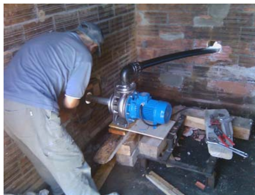
Instal·lació del nou motor elèctric
