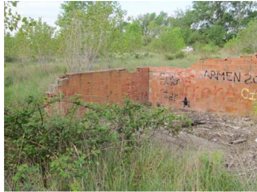
Detall de l'antiga construcció que s'ha retirat
