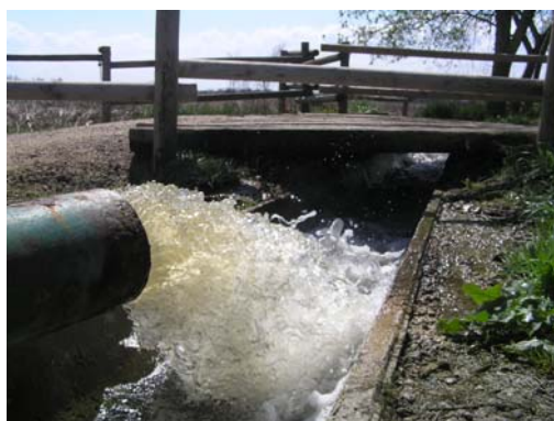
Nou canal de sortida d'aigua del sistema de bombeig al rec d'abastament dels estanys
