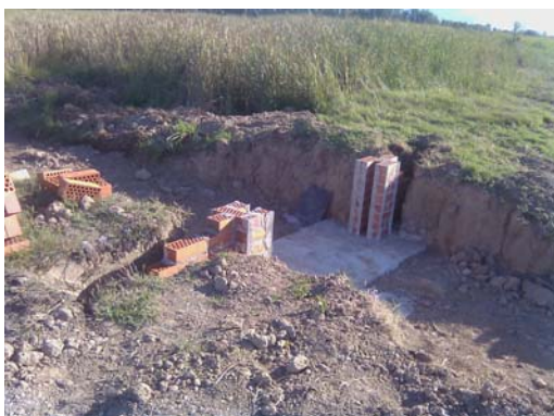
Construcció de les noves arquetes/sobreeixidors
