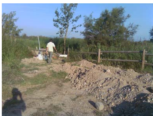
Obertura de la rasa per on s'ha fet passar la línia elèctrica que alimenta el motors elèctrics
