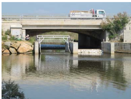
Vista general abans de la col·locació de la 2a comporta
