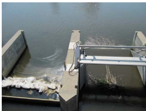
Detall de l'antiga comporta amb sacs de sorra i taulons de fusta
