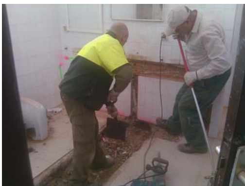
Eliminació de l'antic sistema de d'aigües
