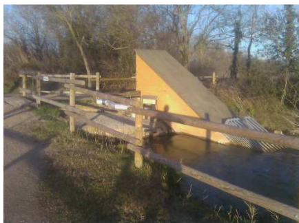
Fot. M17 – Cargol amb tots elements de seguretat.
