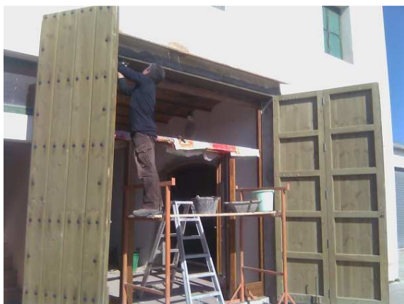
Fot. M1 - Substitució de tancaments exteriors.
