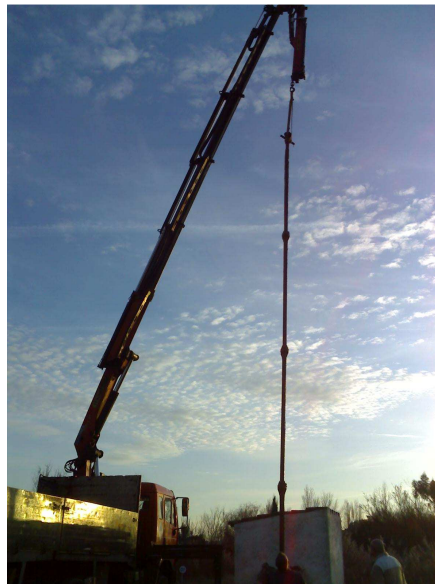
Fot. M21 – Extracció de l'antiga bomba.
