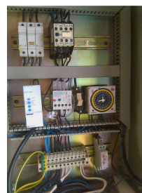
Fot. M9 - Quadre elèctric de comandaments
