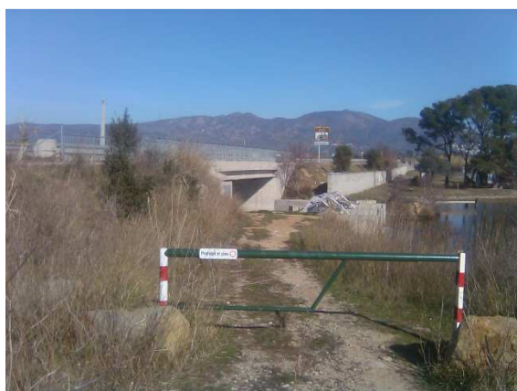
Fot. M28 – La portallera d'accés a la porta basculant
