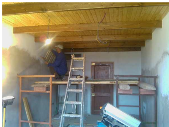
Fot. M2 -. Instal·lació del fals sostre de fusta.
