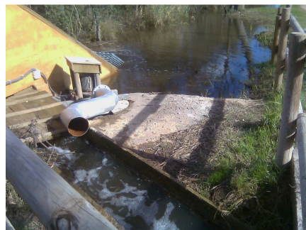
Fot. M18 – Aprofitament de l'antiga bomba en paral·lel.
