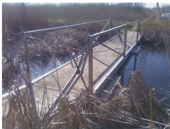
Fot. M6 – Pont de servei a la RNI1.
