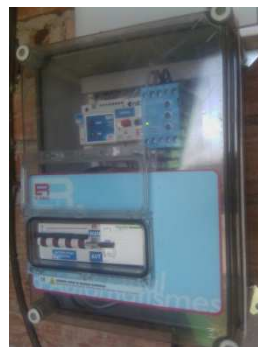
Fot. M23 – Quadre de comandament.
