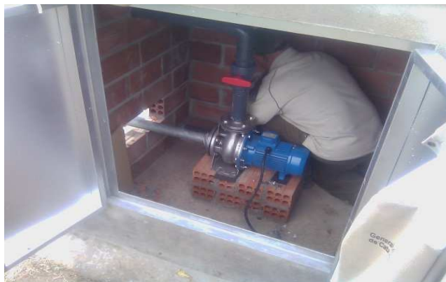
Fot. M19 – Instal·lació d'un motor elèctric.
