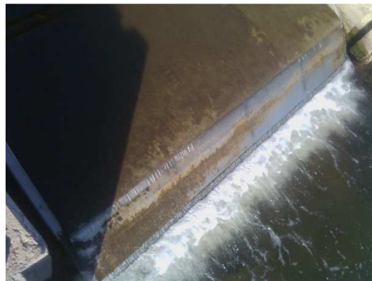
Fot. M37 – Rampa de pas.
