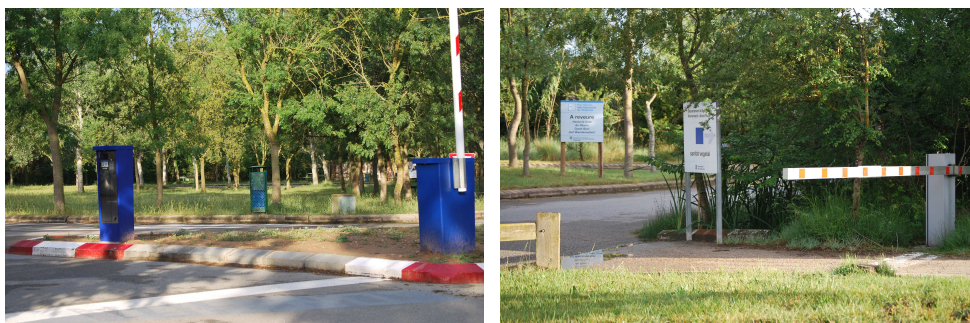
Sistema de barreres, aparcament Cortalet.
