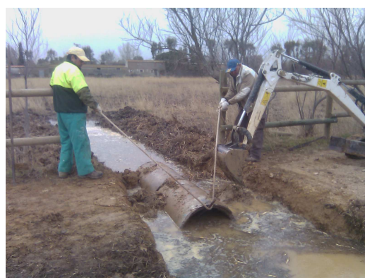
Neteja de motes i instal·lació de tubs de formigó.
