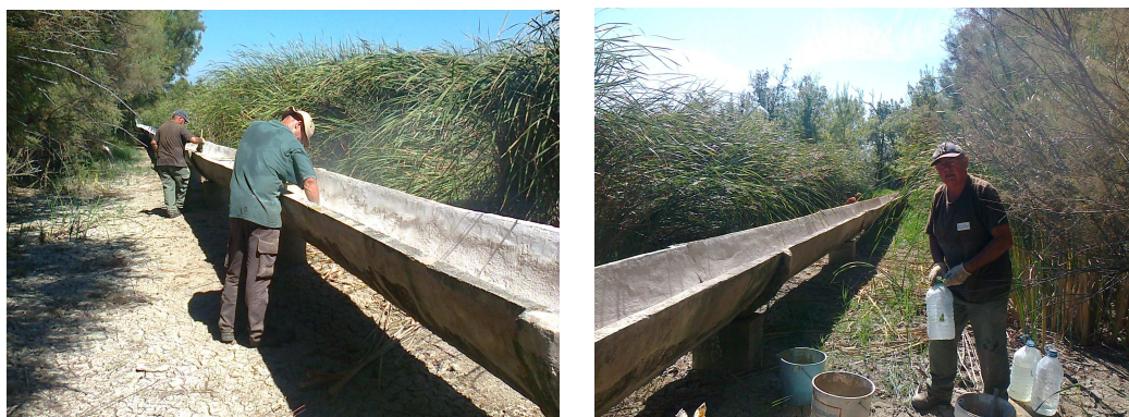
Reparació de la canal del filtre verd
