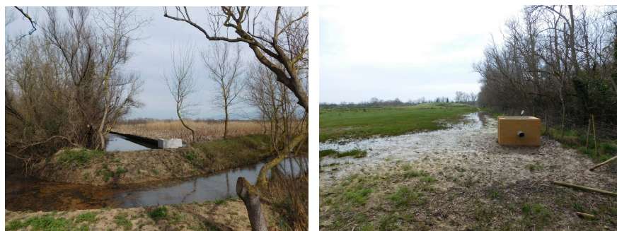
Fot. M10 i M11 – Sistema de inundació a la closa del Cassot de la bomba.
