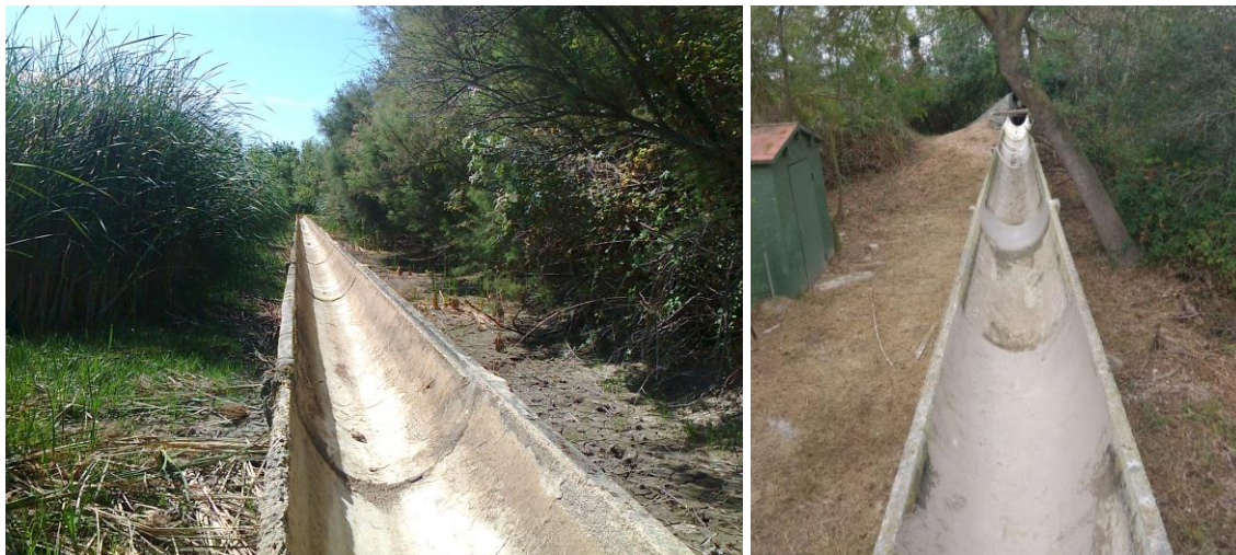
Fot. M11 i M12 – Canal de vessament al filtre verd i canal d'aportació d'aigua al CRF.
