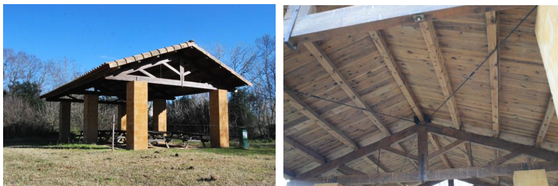
Fot. M5 i M6 – Cobert pícnic al Cortalet. Estructura metàl·lica de reforç.
