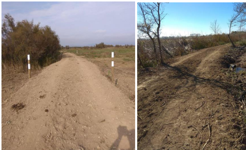
Fot. M7 i M8 – Millora de camins. Riereta (esq.) i La Rajoleria (dreta).
