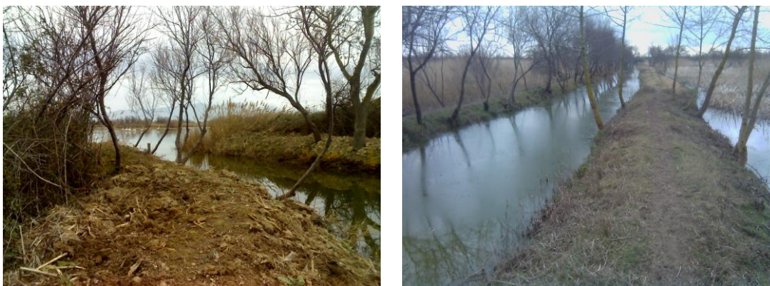
Fot. M9 i M10 - El filtre verd en funcionament després del manteniment.
