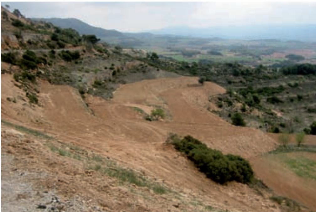
Abocador definitiu restaurat morfològicament en terrasses seguint les formes ondulades del terreny de l'entorn
