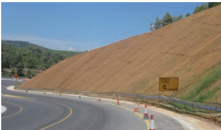
Col·locació de manta orgànica per establir el talús facilitant la retenció de la terra vegetal i l'èxit de la hidrosembra
