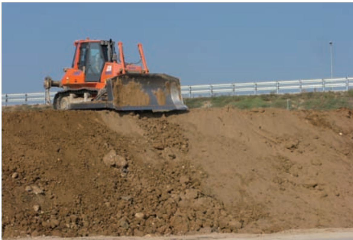
Estesa de terra vegetal en talús
