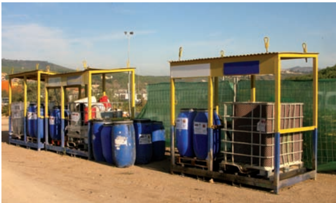
Residus especials sota cobert i en cisternes petites estanques aïllades del sòl
