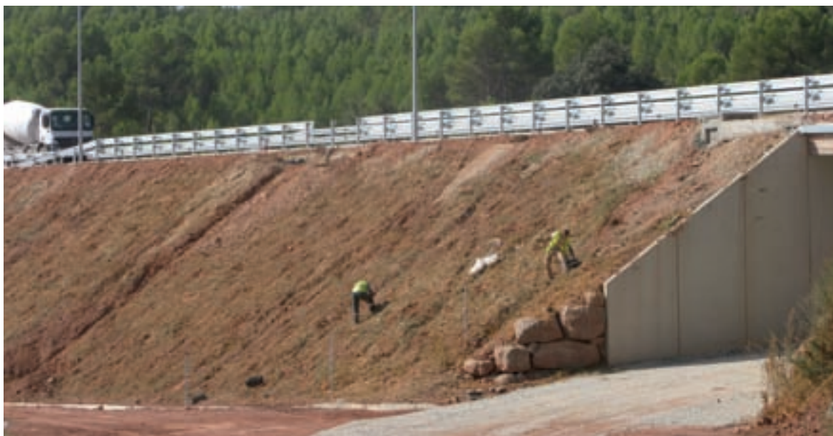
Treballs de plantació d'un talús
