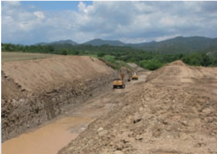
Obertura d'una nova carretera
