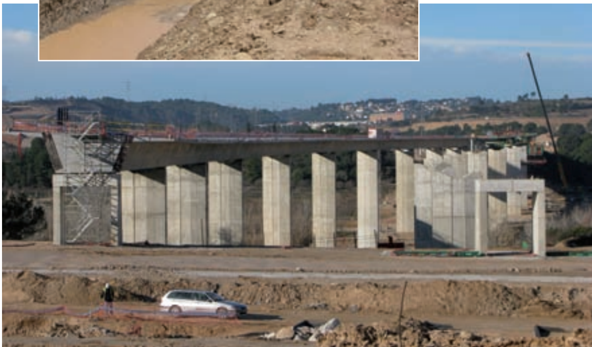
Construcció d'un viaducte
