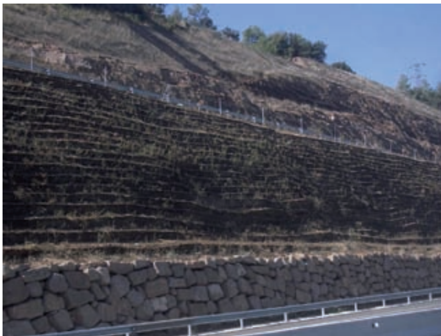
Aplicació de tècniques mixtes d'estabilització i revegetació de talussos: T-verd
