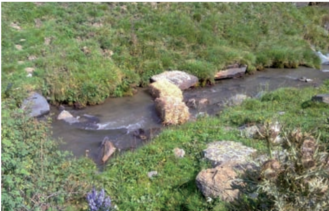
Col·locació de bales de palla com a barrera de retenció de sediments
