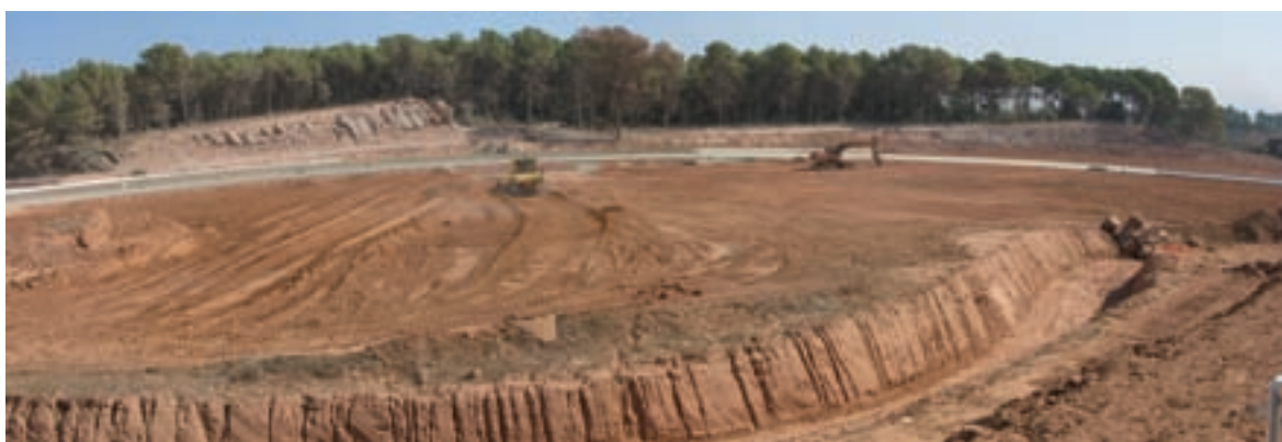
Treballs de restauració morfològica d'una zona d'enllaç afectada per les obres
