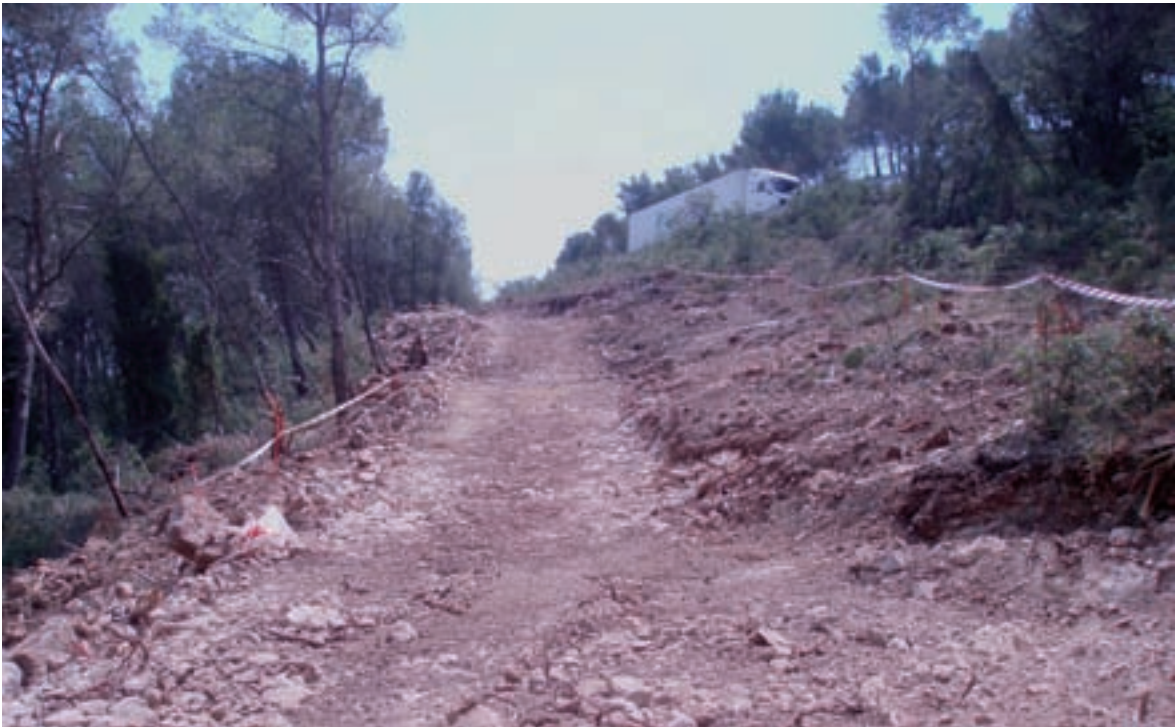
Desbrossada per a l'obertura d'un camí. Els límits estan degudament senyalitzats
