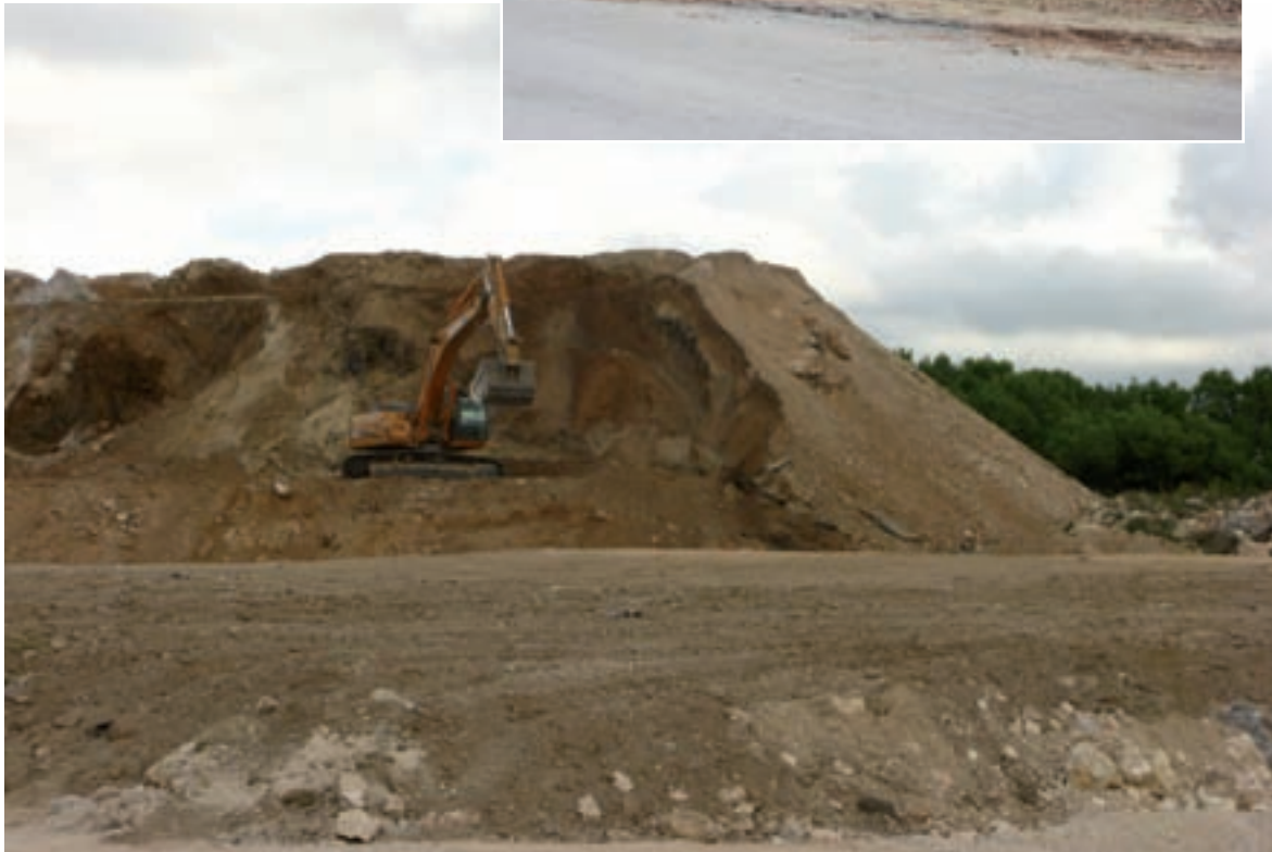
Retirada de provisions de terra en una zona d'ocupació temporal
