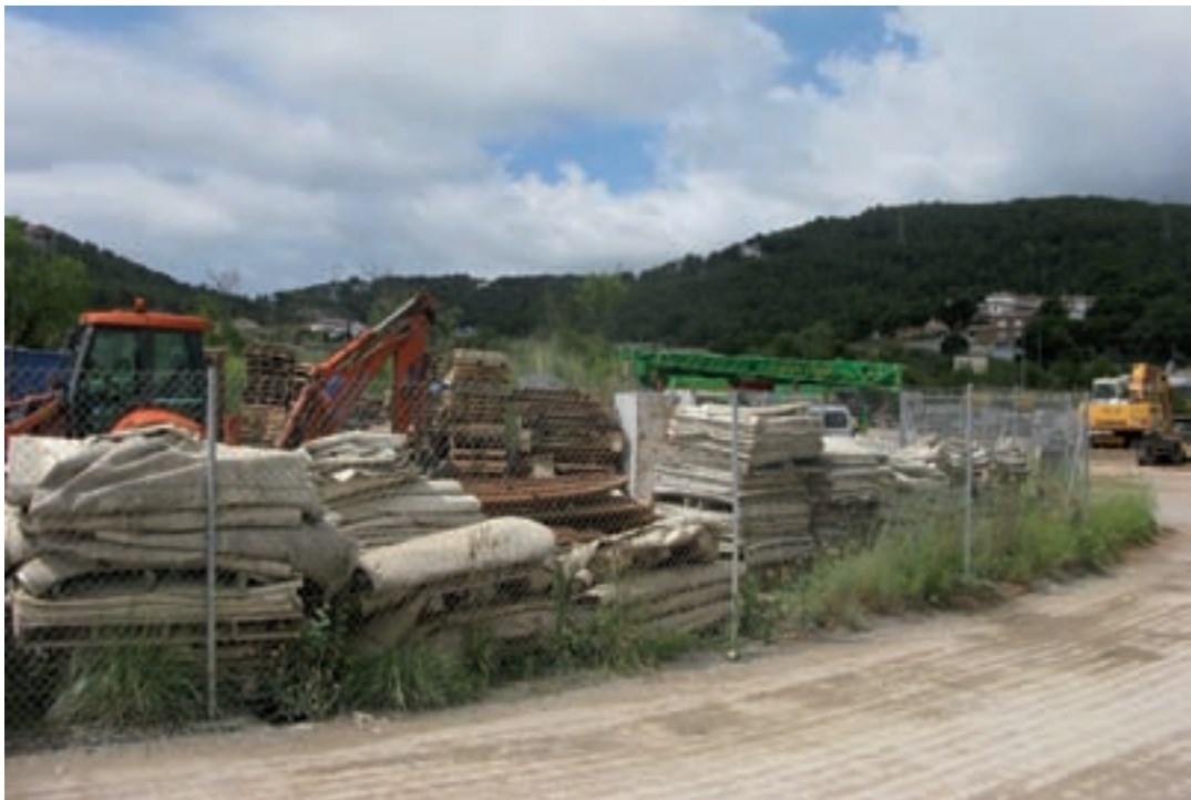
Zona d'ocupació temporal: emmagatzematge de materials de l'obra
