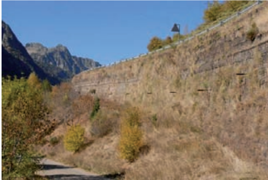
Aplicació de tècniques mixtes d'estabilització i revegetació de talussos: Mur verd
