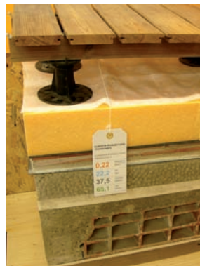
Avaluació ambiental d'una coberta amb paviment flotant. Estand del DMAH a Construmat 2007. Font: Sabatè associats Arquitectura i Sostenibilitat.
