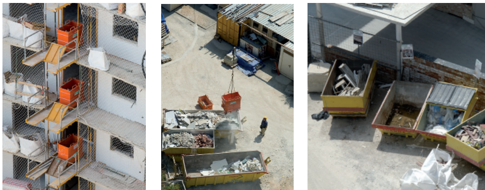
Imatges de la separació selectiva i del procés de transport i emmagatzematge dels residus
