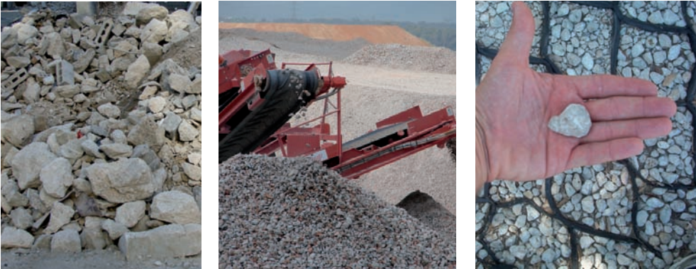
Separació de restes d'estructures, trituració de runa neta i obtenció d'àrid reciclat.
