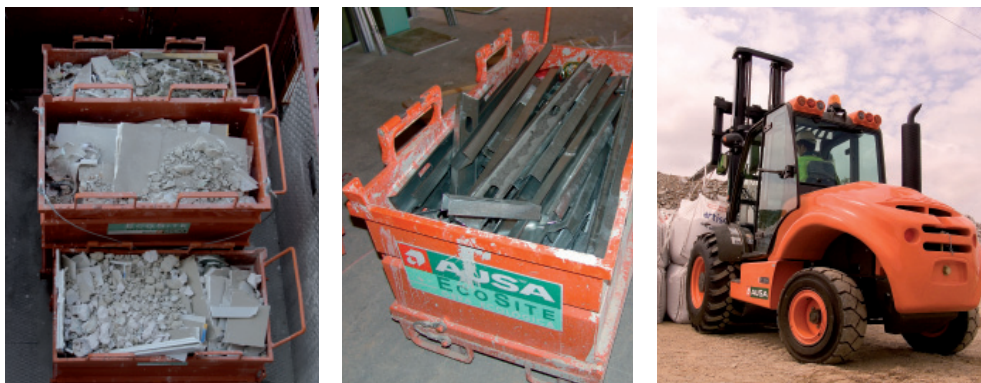
Diversos mitjans d'emmagatzematge i transport i formació a peu d'obra de residus separats per fraccions
