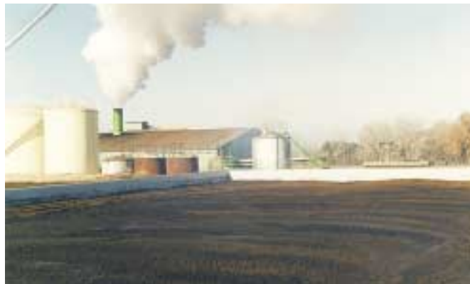
Instal·lació d'assecatge d'oliassa de 3 fases i oliassa humida
