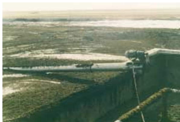
Basses de sansa humida i extracció per cargol sensefi
