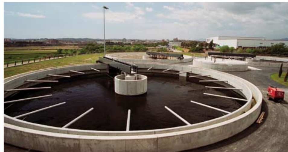
Estació Depuradora d'Aigües Residuals (EDAR)
