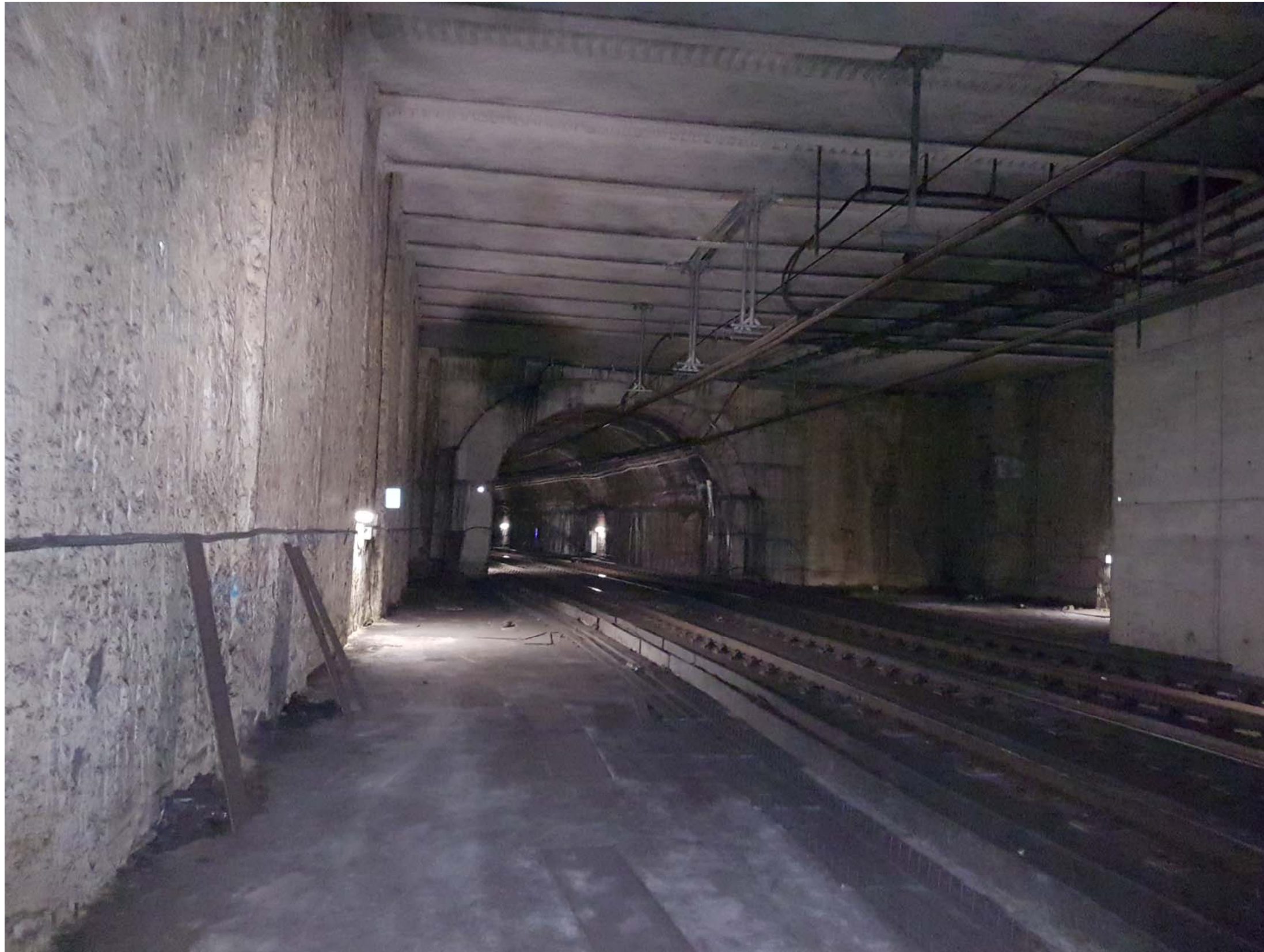
Entrada de materials a sotscentral. Nivell andana, mirant cap a Collblanc
