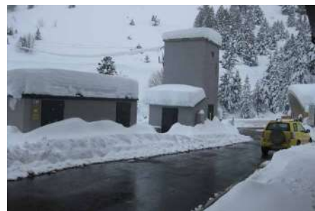
Túnel de Bielsa (España-Francia)
