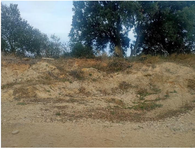
Fotografia 9. Zona de moviment de terres i talús de desmunt amb processos de lliscaments i erosió amb la formació de xaragalls i remobilització de terres. Camí de Siurana. Àrea C3 Perillositat baixa
