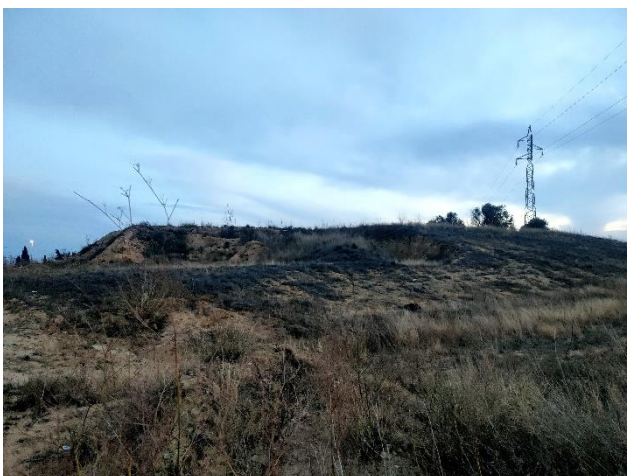
Fotografia 6. Zona amb moviments de terres i talussos artificials amb processos de lliscaments i erosió amb la formació de xaragalls i remobilització de terres. Mas del Mig. Àrea B4 Perillositat baixa
